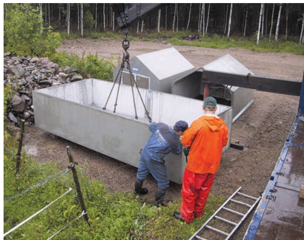
Betongdelen ställs på plats på en plan och väl avgrusad yta.
