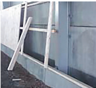
Betongvägg mot stålstomme med konsol för sarg.
