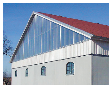
Oisolerat ridhus med stort ljusinsläpp på gavlarna.
