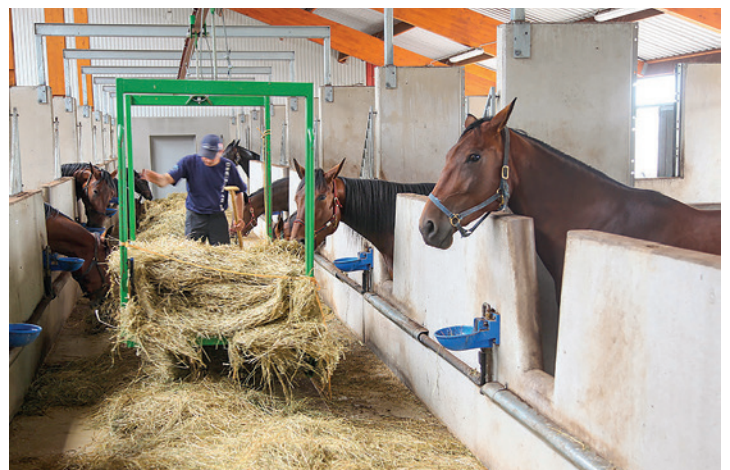
Foderbord med ätfronter i betong. Rundad kant i ätöppningen.
