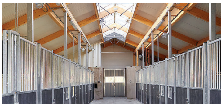
Isolerat stall med öppet upp tillnock.
