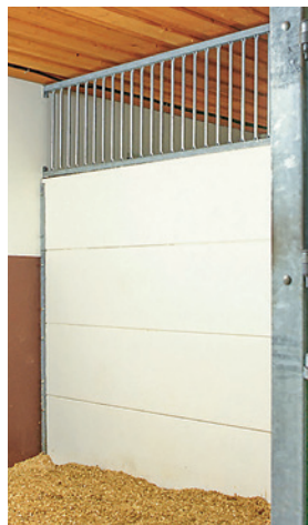
Stapelbara betongplank underlättar montage i befintliga stall.
