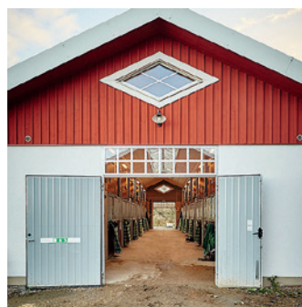
Port med taköverljus.
