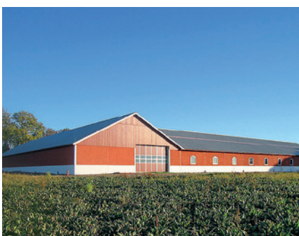
Oisolerat ridhus kombinerat med maskinhall.
