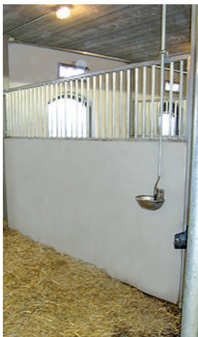
Halvhög betongmellanvägg med galler.
