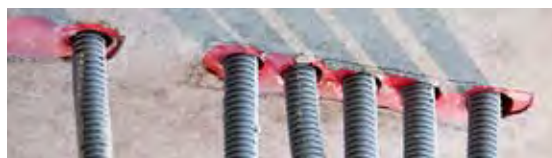
Elgenomföringar placeras i anslutning till lättväggar.
