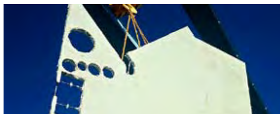
Plattbärlagen kan utformas med stor exakthet även vid speciella former.
