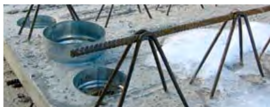
Ventilationsstos och ventilationsmuff förenklar rördragningar på plats.
