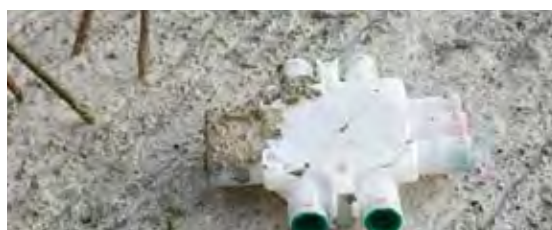
Förhöjd eldosa förenklar åtkomligheten vid installation.
