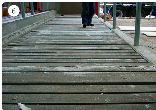
Nu är hela golvet lagt. På bilden syns att var 10:e spaltstav ligger högre.
